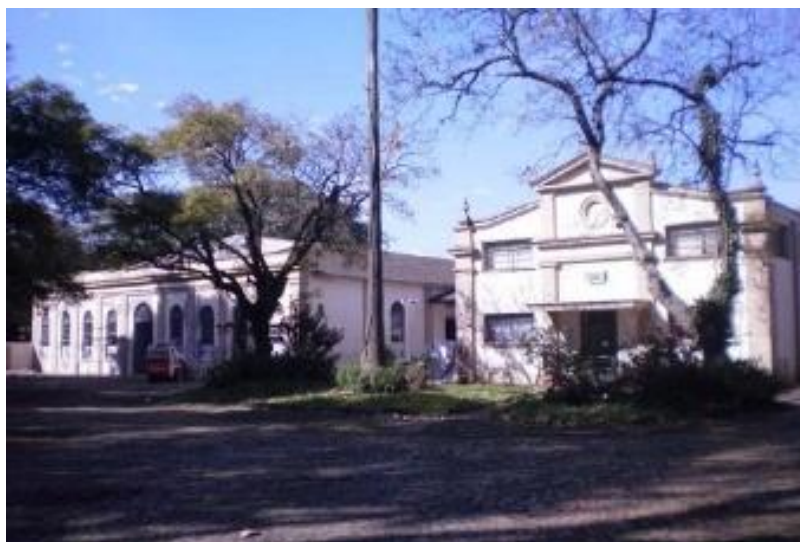
Fotos 2: Instalações fábrica têxtil FIATECI, 2009.
